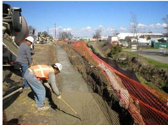
Figure 2-23. Concrete pour adjacent to Drainage #30
