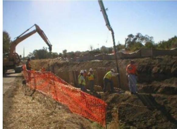
Figure 2-15. Concrete pour over the conduit installation within Drainage #30
