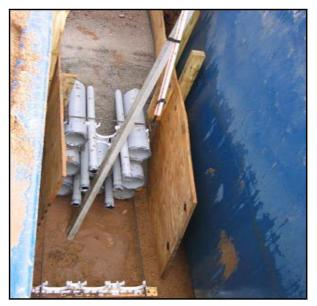
Figure 10 - Conduit Placement
