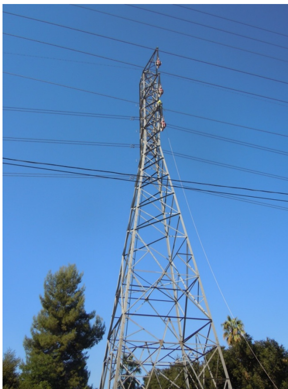
Figure 5: A PAR lineman removes a traveler, Segment 11.
