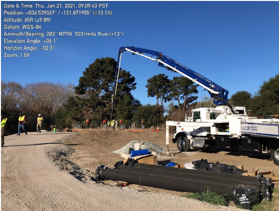
Photo 1. Concrete pour at pad.
