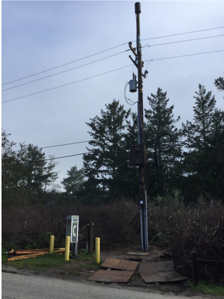
Photo 4: Split-rail fence at Año Nuevo kiosk requires repair.
