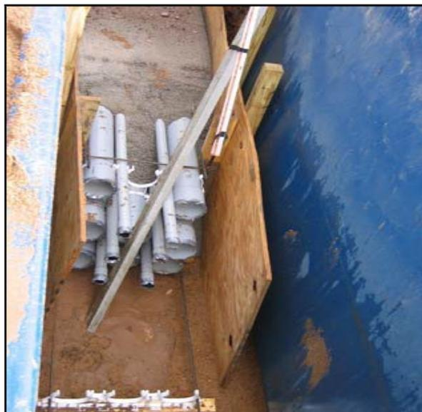
Figure 10 – Conduit Placement
